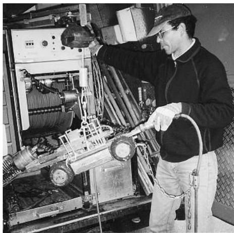
*Das Auto mit Scheinwerfer und Fernsehkamera wird aus einem Kontrollschacht gehievt (ulr)*
