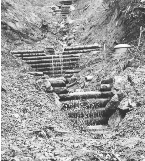
Nach den Hochwasserschäden wurde im Affoltertobel der Bach im Bereich der Wasserfassungen weich verbaut
