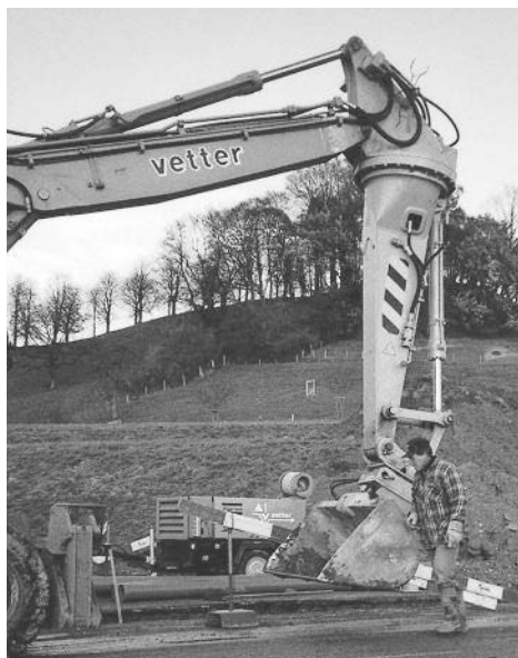
Genügend Wasser und Strom gehören zur Infrastruktur einer Gemeinde – Leitungsbau Lustdorf–Wetzikon
