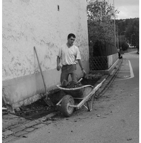
Sicherung des Fussgängerbereiches an der Matzingerstrasse
