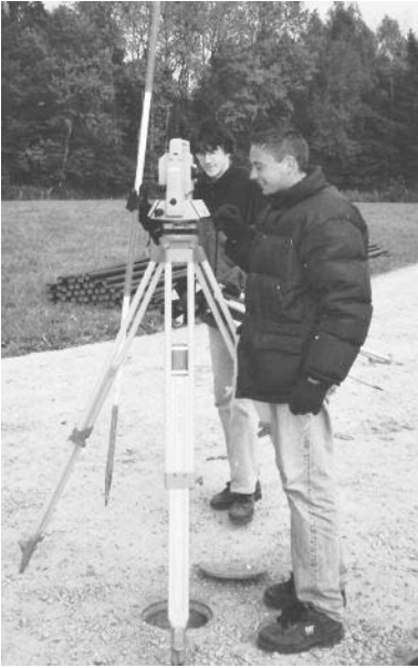
Start zu den Bauarbeiten: Die Vermesser markieren Grenz- und Fixpunkte beim Gertschhauserweiher
