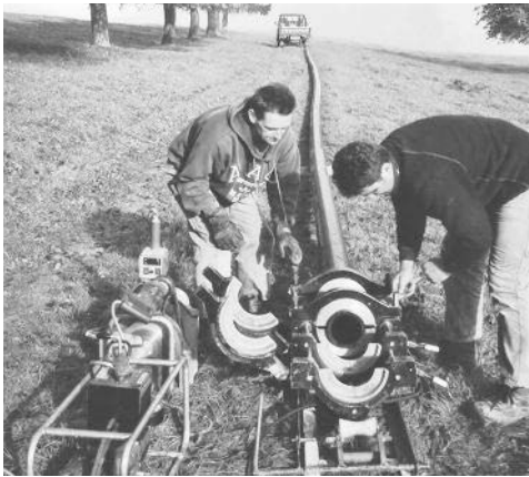
Die neue Wasser- leitung zum Homberg wird zusamme- geschweisst, so dass sie den Druck von 16 bar aushält
